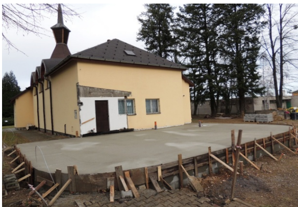
SOUČASNÝ STAV - DOKONČENÍ ZÁKLADOVÉ DESKY:
